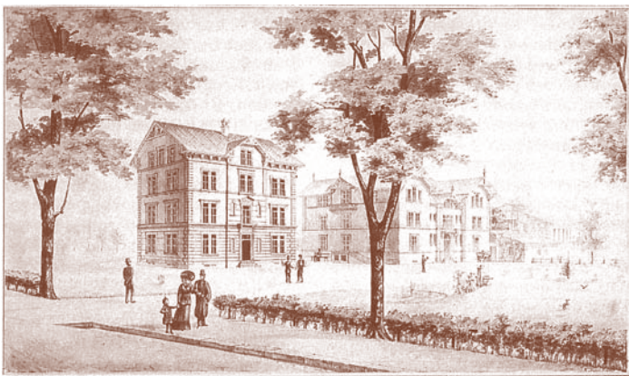
Das Seminar nach 1880. Im zweiten wesentlich schlichter gehaltenen Schulhausbau war ursprünglich die Musterschule untergebracht.
